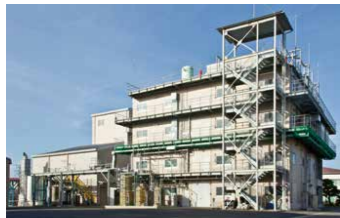
有機ヨウ素化合物製造設備
