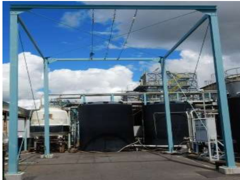
写真：墜落制止用器具のフックを取付けるための設備の設置
