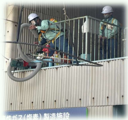
塩素漏洩個所の修理作業
